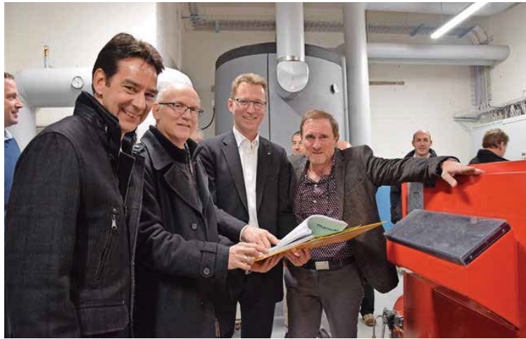
Besichtigung der sanierten Heizung im GVS-Gebäude in Herblingen durch Thomas Volken, Andrea Paoli, Thomas Kellenberger und Antonio Filomeno (von links).
